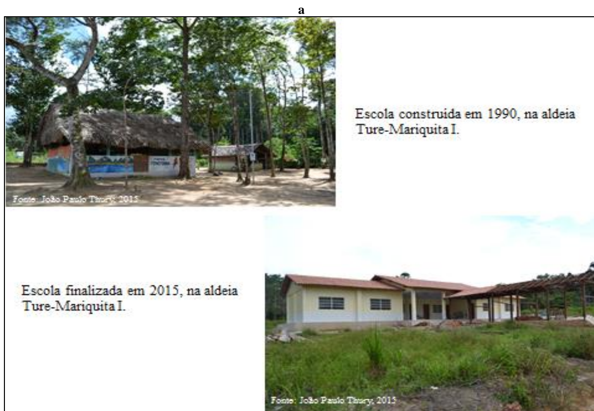
Figura 3 - Antes e depois da construção da nova escola.
