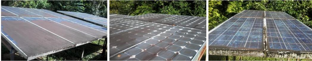
Na Figura 1.4 observa-se o sistema após a revitalização e ampliação, entretanto, o efeito do sombreamento ainda é observado, e dessa vez, se deve as árvores do entorno do GFV, caracterizando não, mas um sombreamento temporário, mas sim devido a um sombreamento em consequência da localização que já existia durante sua implantação, que se intensificou com o crescimento das árvores ao longo desses nove anos.
