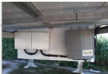
Quanto à monitoração do sistema, o *datalogger* coletava, a cada 5 minutos, informações elétricas do inversor tais como: tensão c.c., tensão c.a. e potência c.a., além de temperatura de costa do módulo FV e irradiância no plano de gerador, ambas provenientes do *sensor box*. Esses dados eram armazenados na memória interna, com capacidade de 500 Kbytes (suporta aproximadamente 1000 dias de dados e, após esse período, começa a sobrescrever os dias mais antigos).
