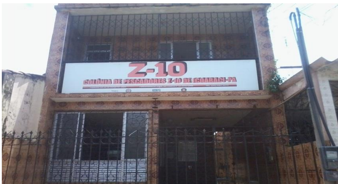
Figura 5: Instalações da Colônia de Pescadores Z-10 de Icoaraci.
