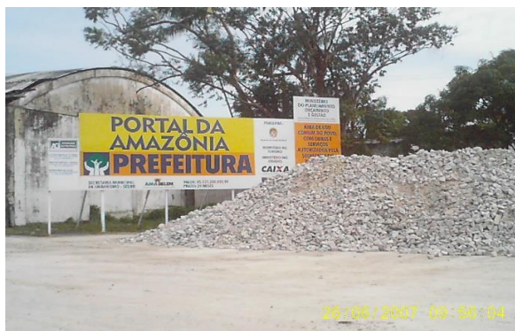
Fotografia 11 - Sinalização do canteiro de obras
