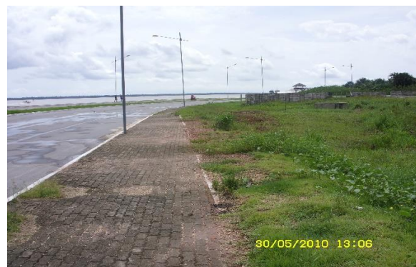
Fotografia 12 - A obra em maio de 2010 já com aterramento e asfaltamento
