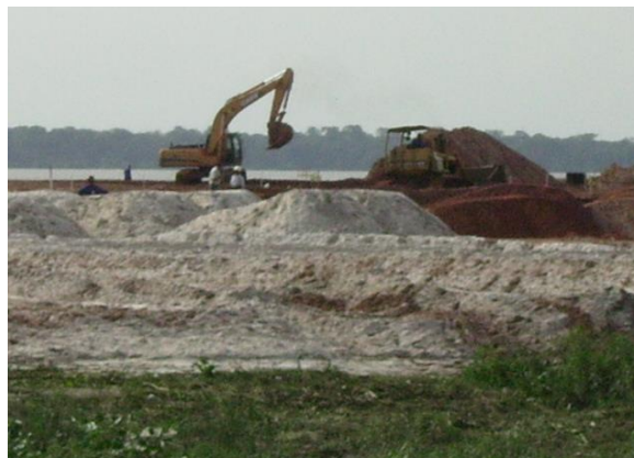
Fotografia 14 - Aplicação da areia oriunda de jazida no aterramento da orla
