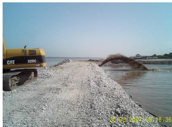
Fotografia 10 - Aterramento hidráulico das margens do Rio Guamá
