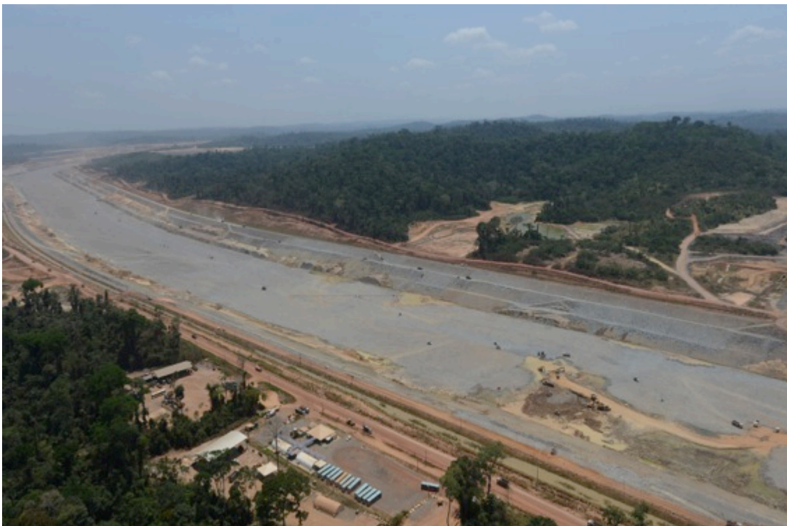
Foto 06: Canal de Derivação.
