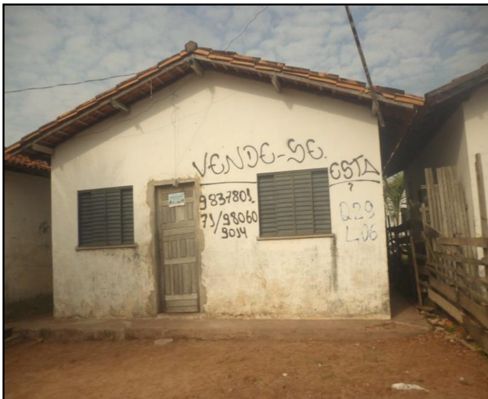
Figura 12: Unidade Habitacional - Rua Vale Azul. Fonte: Odália Borges, 2015.
