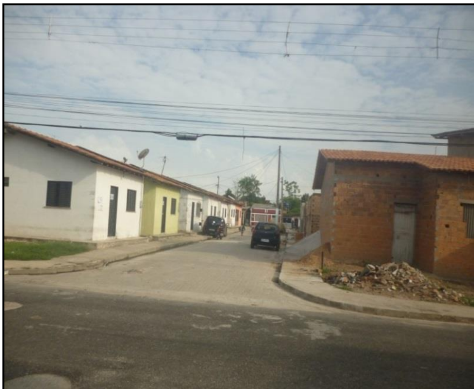
Figura 11: Rua da Feirinha – Moradias construídas pelo PAC Social e Urbano e Programa Cheque Moradia.
