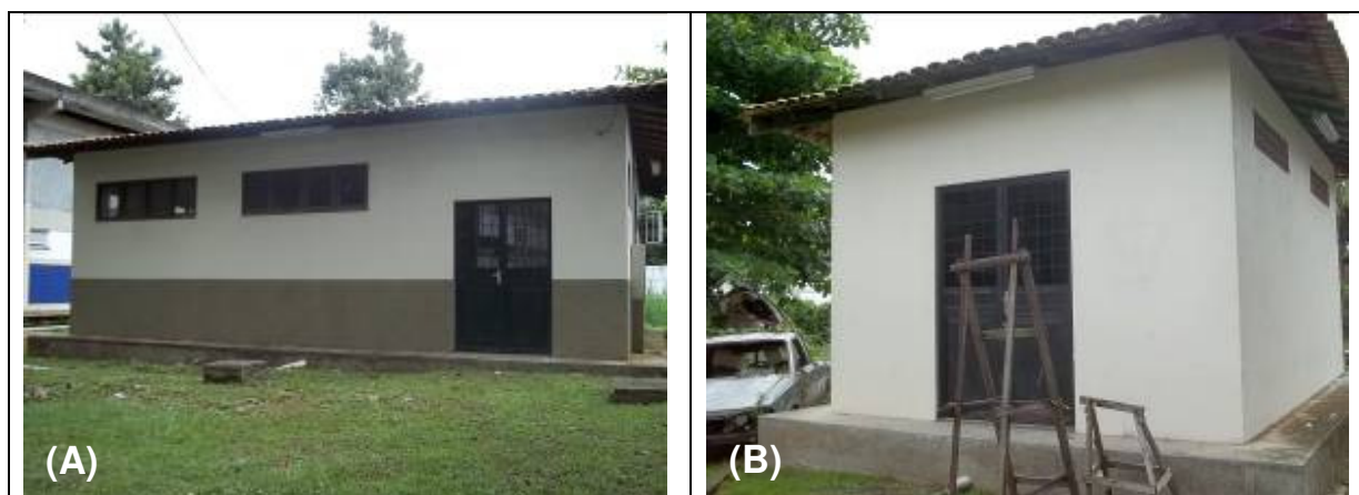
Fotografia 13 – (A) Laboratório de tratamento de resíduos químicos e, (B) entreposto de armazenamento de resíduos químicos.
