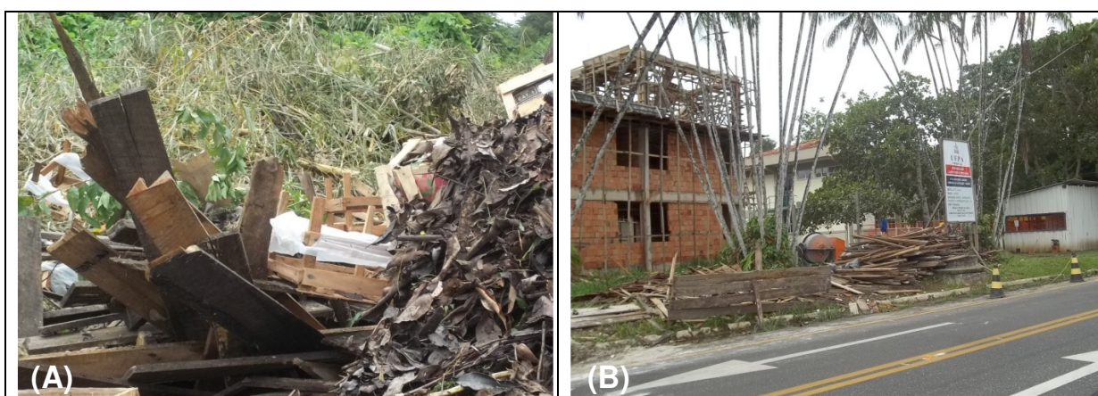
Fotografia 22 – (A) Entulho de obra depositado irregularmente e, (B) resíduos dispostos sem critério em frente à uma obra.
