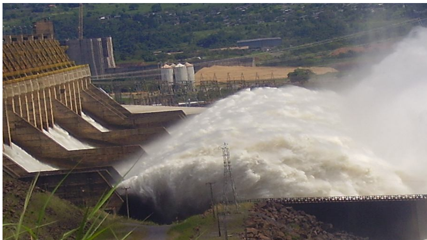
Foto 4 - Vertedouro da represa da UHE de Tucuruí
