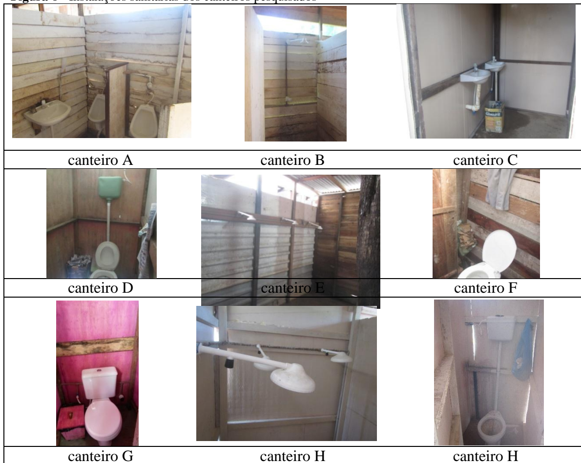
Figura 6 - Instalações sanitárias dos canteiros pesquisados
