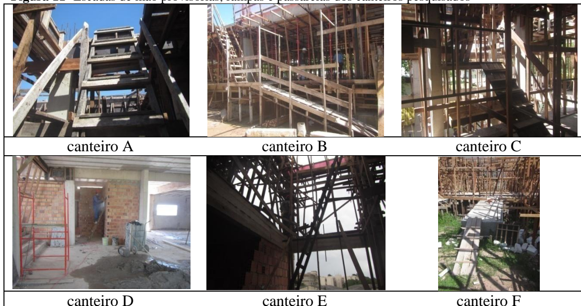
Figura 11 - Escadas de mão provisórias, rampas e passarelas dos canteiros pesquisados
