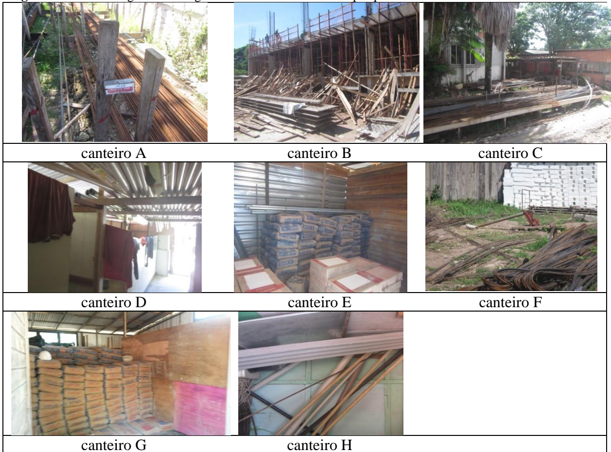
Figura 23 - Armazenagem e estocagem de material dos canteiros pesquisados
