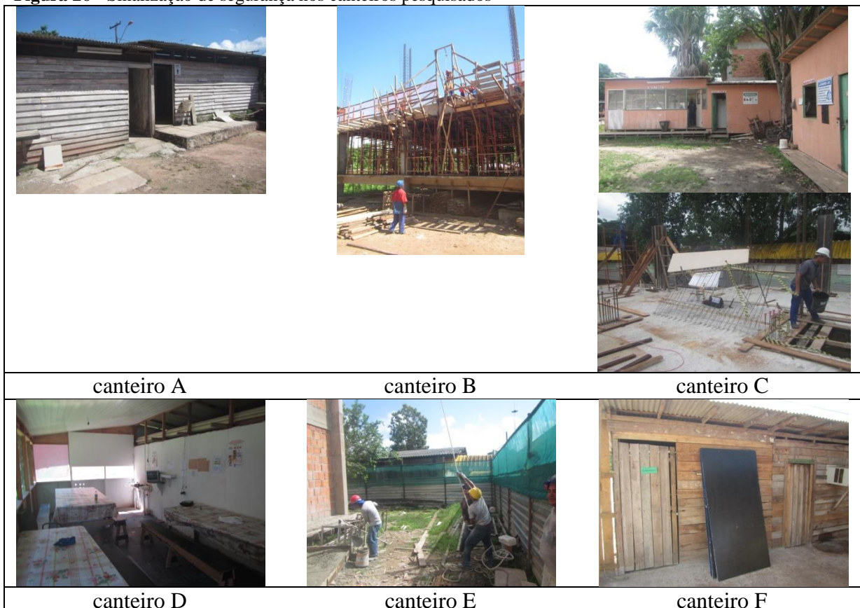
Figura 26 - Sinalização de segurança nos canteiros pesquisados
