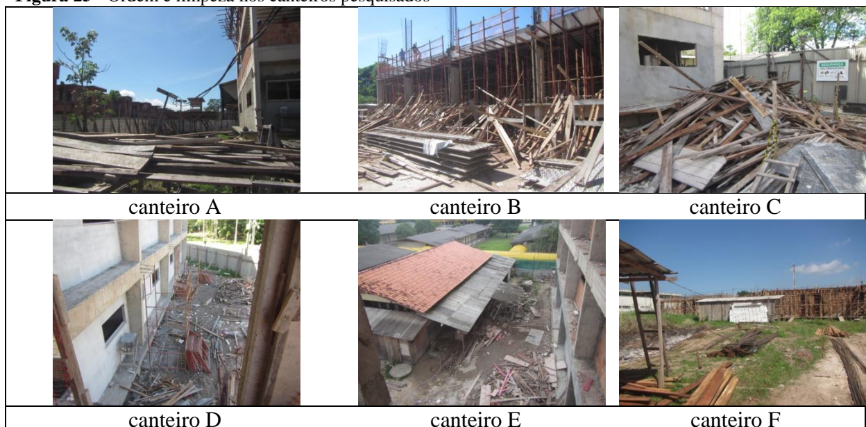
Figura 25 - Ordem e limpeza nos canteiros pesquisados
