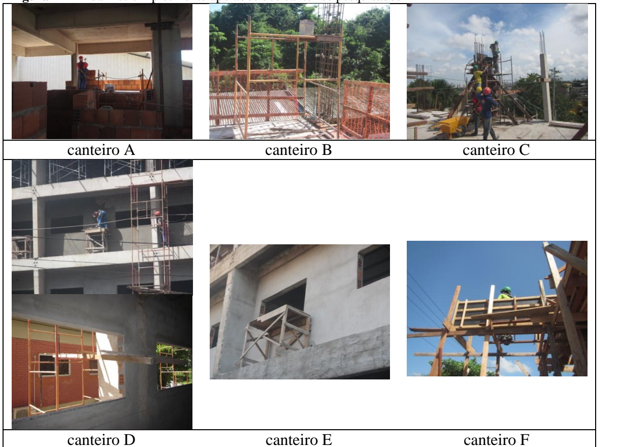
Figura 17- Andaimos simplesmente apoiados dos canteiros pesquisados
