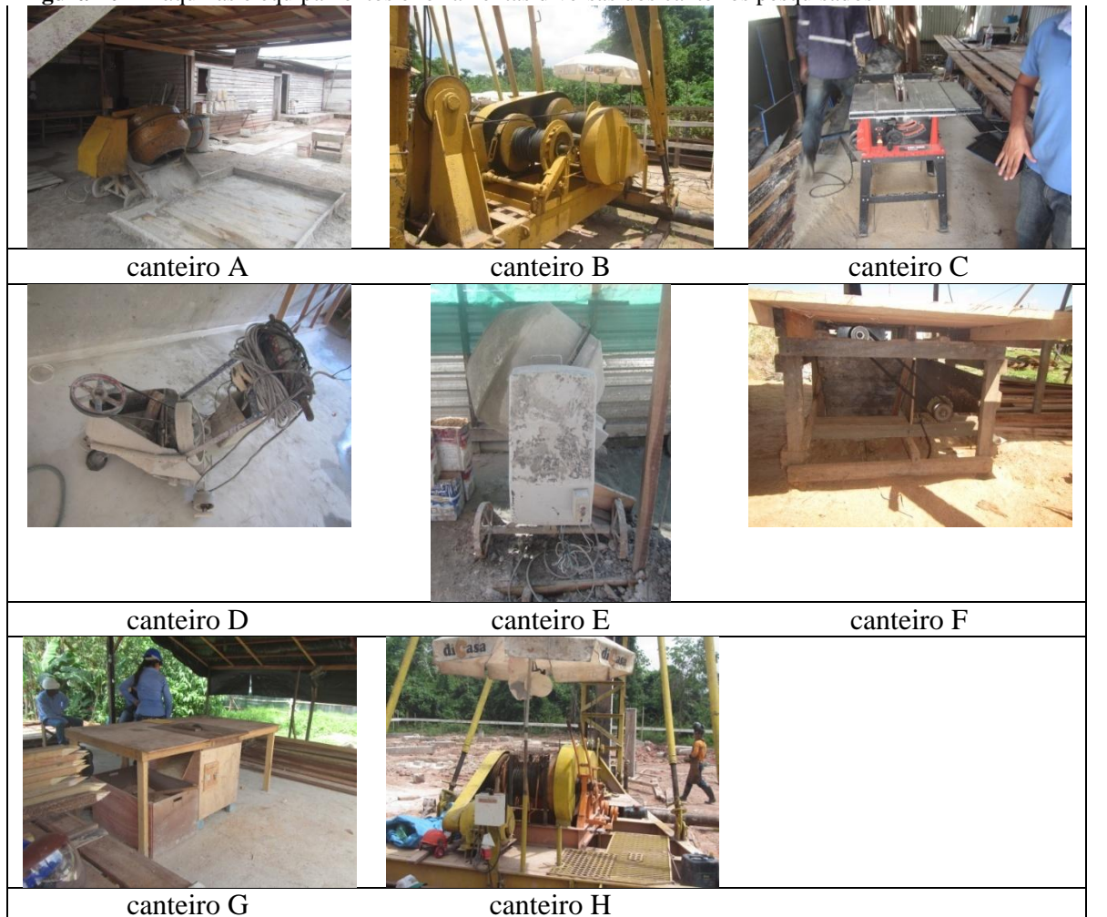
Figura 20 - Máquinas e equipamentos e ferramentas diversas dos canteiros pesquisados
