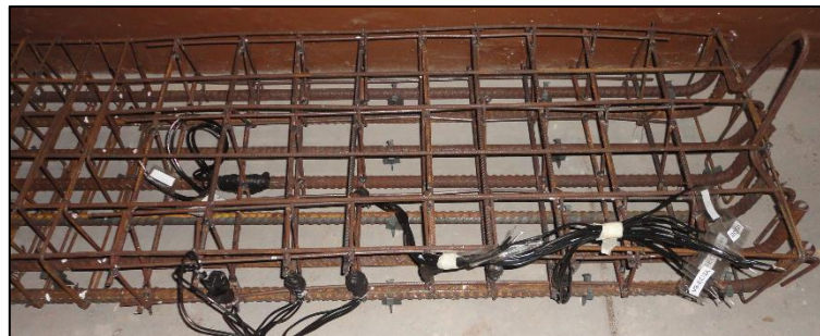
Figura 3.10 - Armadura da viga W-3.5-0.17
