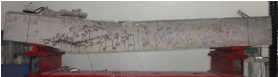
c) Viga após o ensaio
