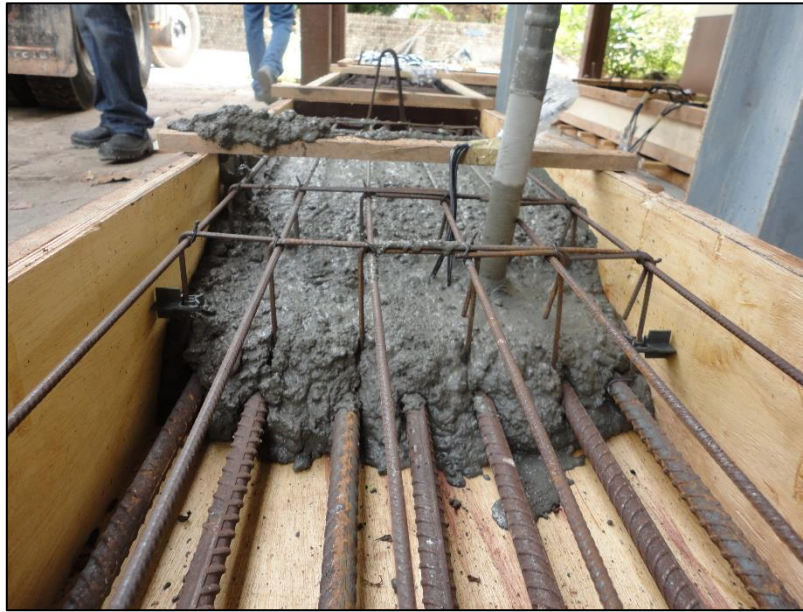
Figura 3.45 - Adensamento do concreto
