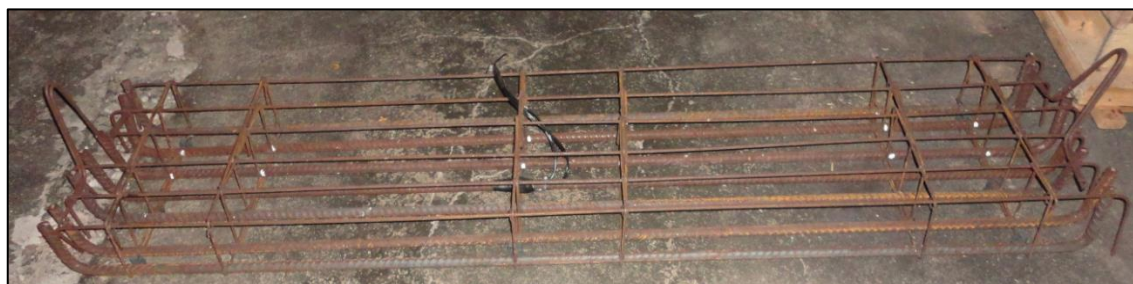
Figura 3.3 - Armadura da viga R-3.5
