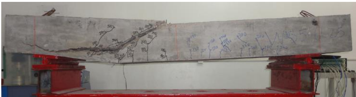
c) Viga após o ensaio
