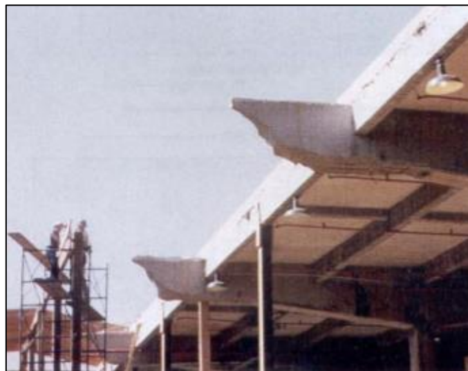
Figura 1.1 - Ruptura por cisalhamento (LUBELL et al. , 2004)
