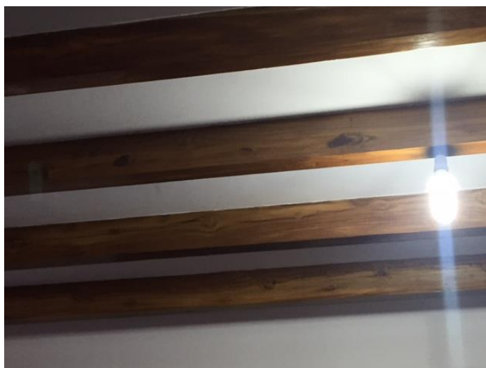
Figura 70 - Piso Acabado com Peças Seladas e Laje Pintada
