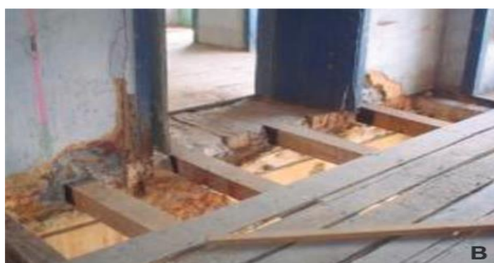
Figura 3 - Montagem de Pisos de Madeira com Apoio em Alvenarias
