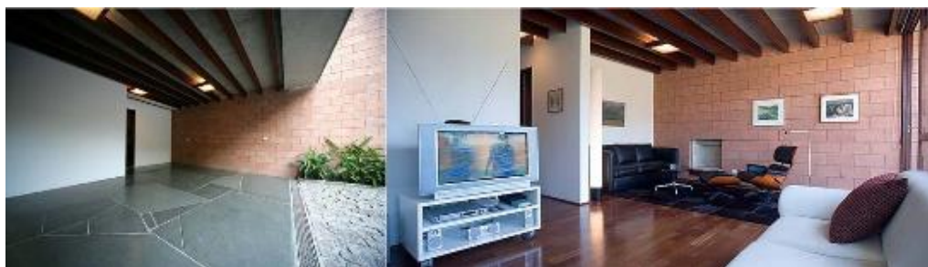
Figura 9 - Pisos de Madeira e Concreto
