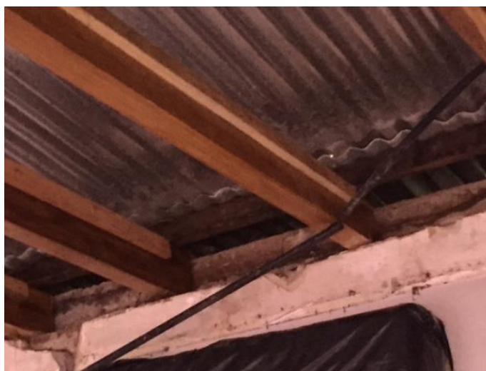
Figura 62 - Colocação das Peças para Chumbamento
