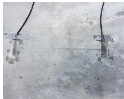
Figura 78 - Aplicação de Silicone
