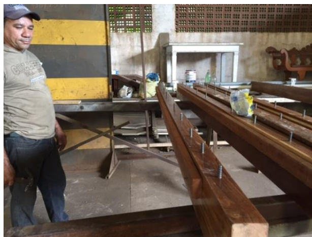
Figura 59 - Conectores Fixados -V1 a V4
