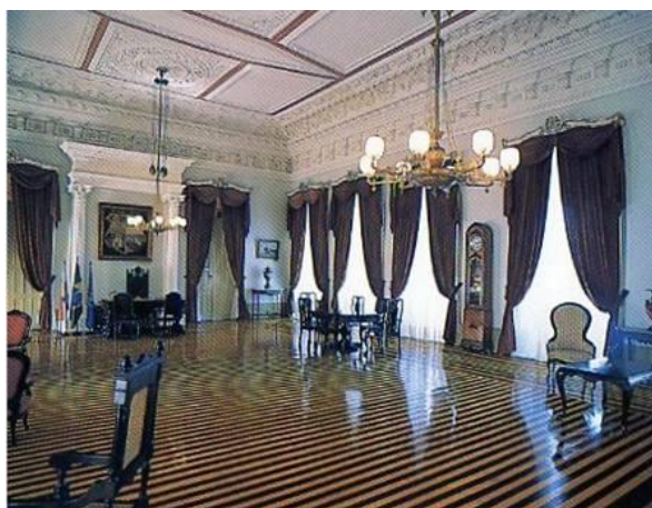
Figura 5 - Amostra de Piso de Acapu e Pau Amarelo - Palácio Antônio Lemos - Belém - Pará
