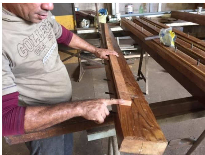
Figura 60 - Alinhamento do Barrotamento
