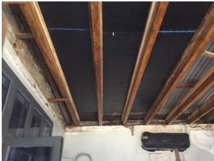
Figura 63 - Alinhamento com o Maderit
