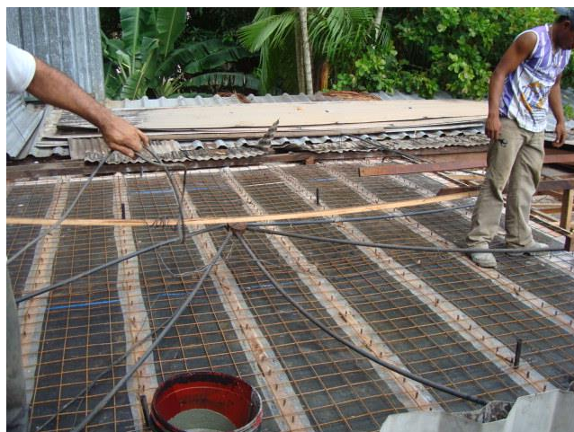
Figura 64 - Assentamento da Armadura Mínima
