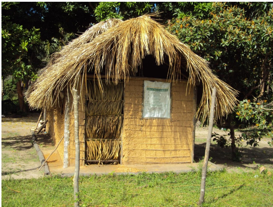
Figura 5.5.1. Residência de taipa na Comunidade Pedral, Município de Soure, Microrregião Arari (PA).
