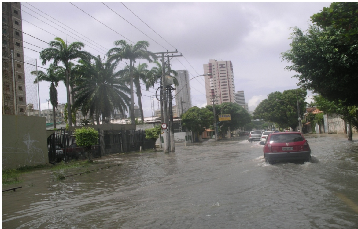
Foto 11. Ponto de inundação na Tv. Padre Eutíquio próximo ao canal da Quintino Bocaiúva.
