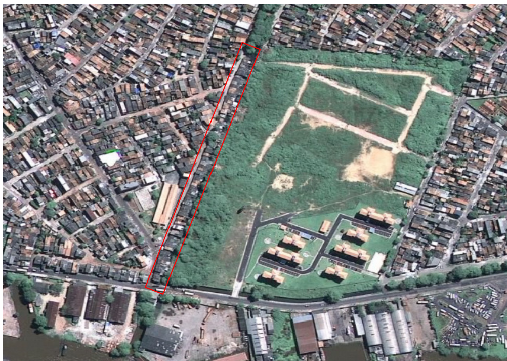
Foto 2. Construções habitacionais construídas sobre o canal (Imagem GeoEye-2010/Google).
