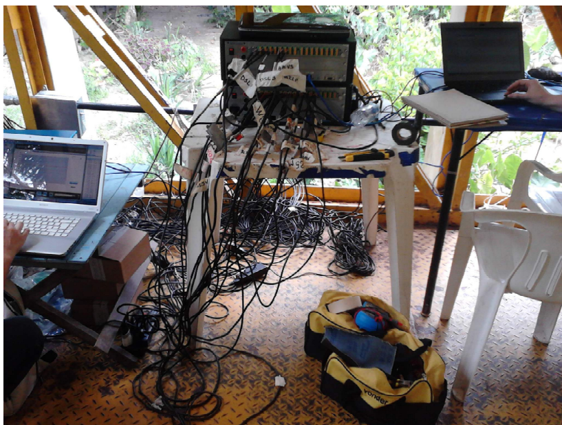
Figura 2.3: ADS2000 conectado a diversos cabos elétricos.
