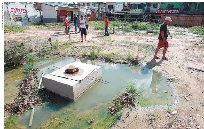
Além de uma história de descaso, nada restou no local onde ficaria o mercado do Distrito Industrial
