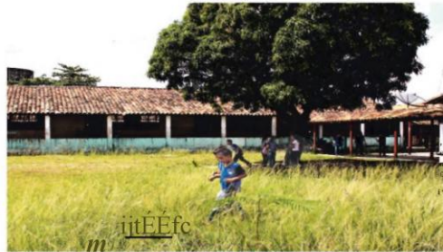
Na Escola Rômulo Maiorana, o matagal toma conta da área externa local
