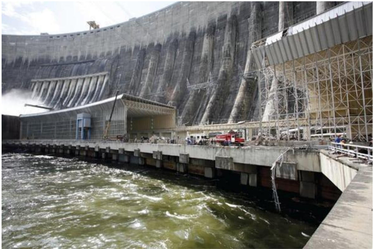
Figura 1 - Barragem de Saïano-Shushenskaya após o desastre de 2009.
