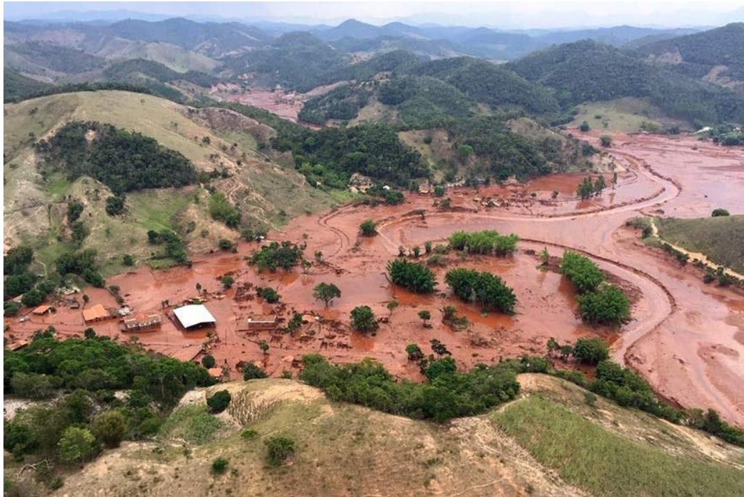
Figura 3 - Desastre do rompimento da barragem de Fundão em Mariana - MG, 2015
