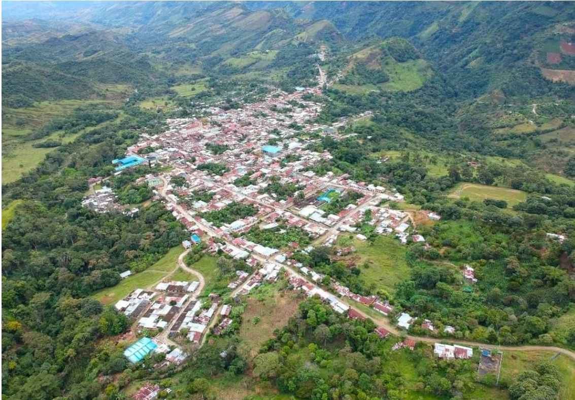
Figura 21. Foto panorámica de la cabecera municipal de San Antonio de Calarma, Tolima, Colombia. Según el censo poblacional del año 2018, el municipio cuenta con 12.570 habitantes, de los cuales 4.265 se ubican en la zona urbana y 8.305 en la zona rural (FOTOGRAFÍA: R. RUBIO, FBK SAN ANTONIO MÁGICO, 2021).
