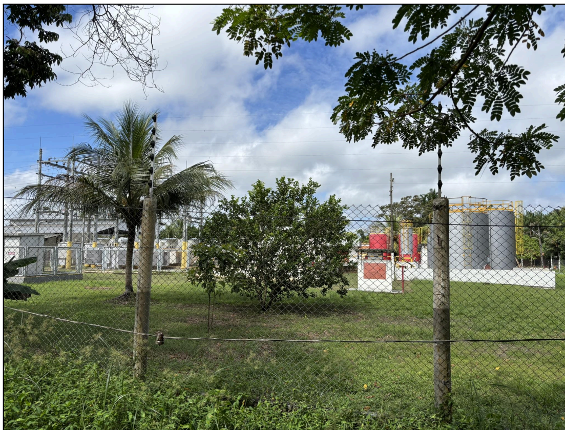
Figura 09 — Estrutura da UTE Muaná.
