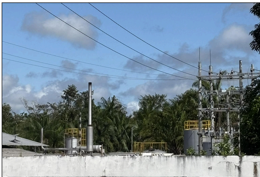
Figura 25 — Estrutura da UTE Muaná.
