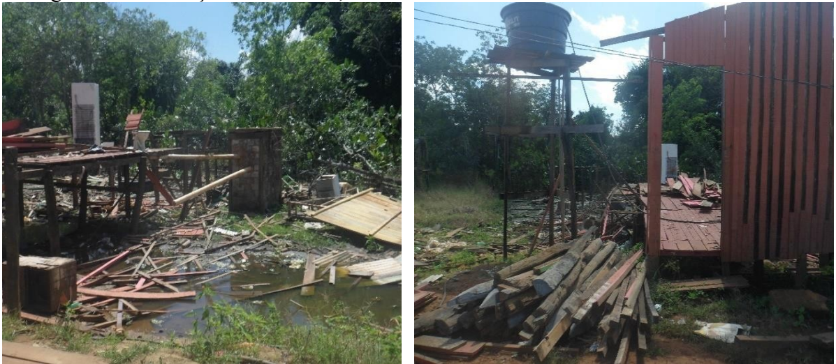
Figura 13 - Habitações nas ADAS, destruídas em detrimento da UHE Belo Monte
