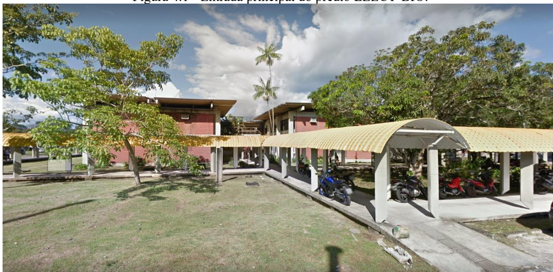
Figura 4.1 - Entrada principal do prédio LEECT-BIO.
