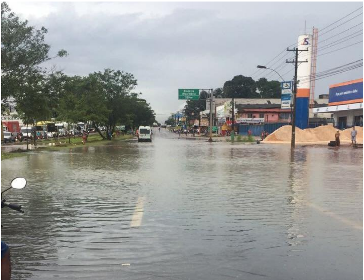
Figura 12- Via BR 316 alagada no mês de março de 2020.
