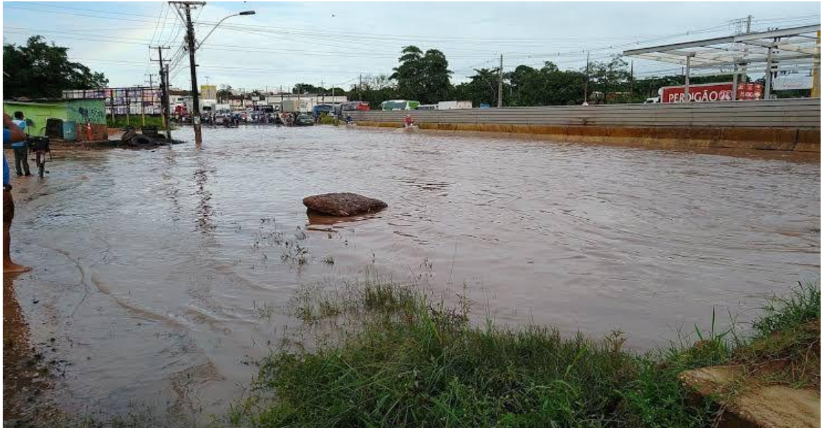
Figura 11- Registro da BR 316 alagada no mês de março de 2020.
