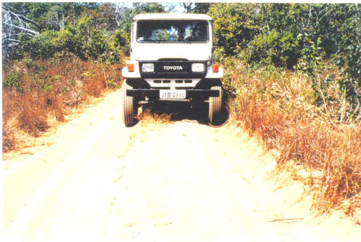
Figura 1.3 - Aspecto apresentado por grande parte das estradas vicinais, que, construídas sobre terrenos arenosos, apresentam condições de tráfego extremamente difíceis na época de estiagem.
