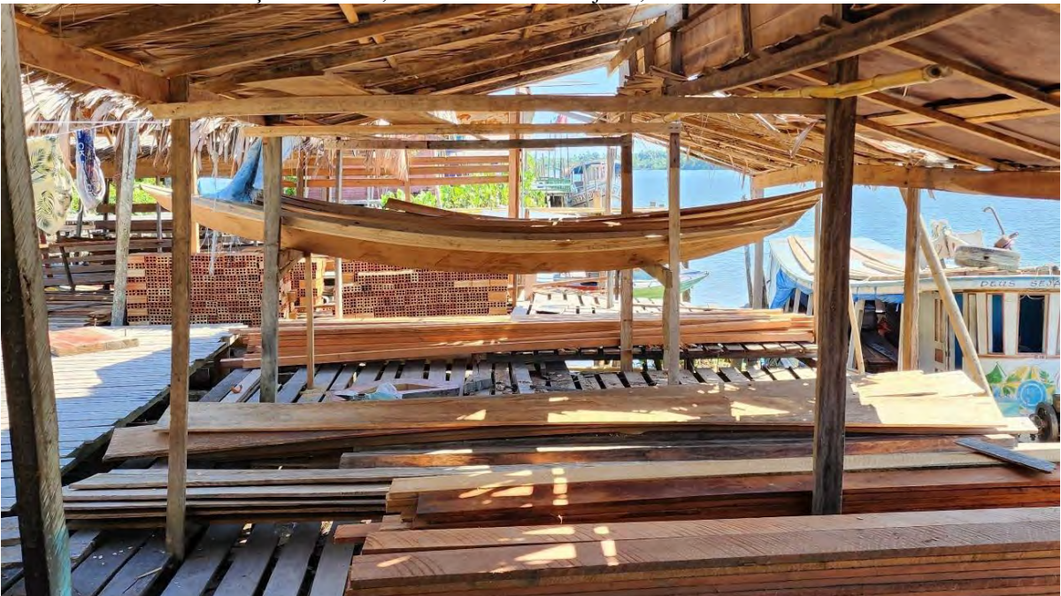
Foto 30 – Local de construção de cascos, venda de madeira e tijolos, na Vila do Pirizinho.
