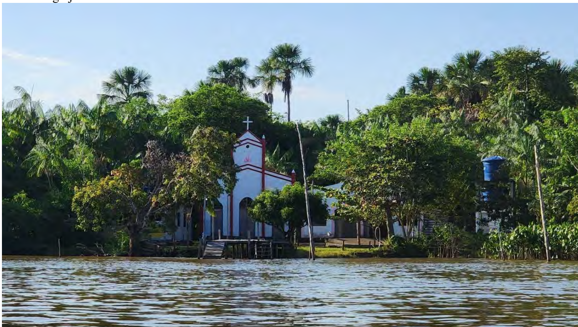
Foto 2 – Igreja Nossa Senhora do Bom Remédio.
