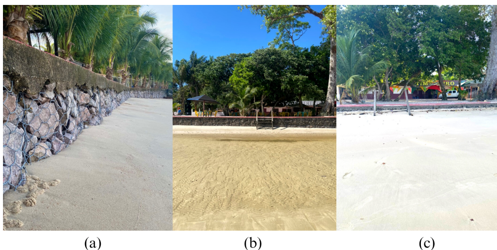
Figura 11. Estrutura de intervenção costeira na praia do Caripi; (a) Muro do tipo Gabião; (b) Remoção sedimentar da face praial na estação chuvosa no setor leste e (c) Deposição sedimentar no período seco.
