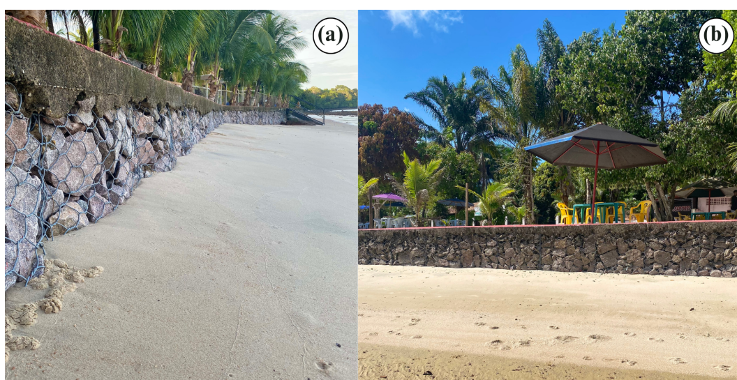
Figura 14 - Muro de contenção costeira (gabião) (a) visualização lateral da estrutura; (b) visualização frontal. Fonte: Autora.
