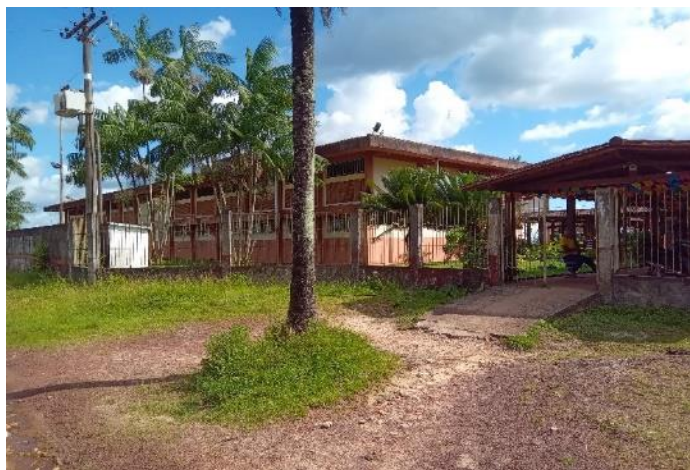
Figura 1 – Faixada da Escola Celso Rodrigues.
