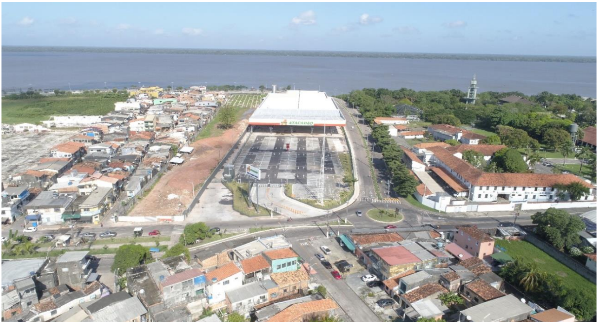
Fotografia 3 – Logradouro público para acesso à orla do Portal da Amazônia
