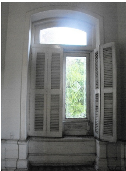
Figura 10: Vidraças na folha externa e venezianas de madeira na interna, Palacete Bibi Costa, Belém, Pará.
