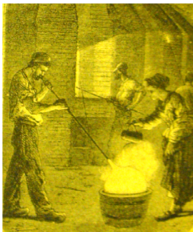
Figura 39: Trabalho da pasta vítrea fundida dentro do cadinho.
