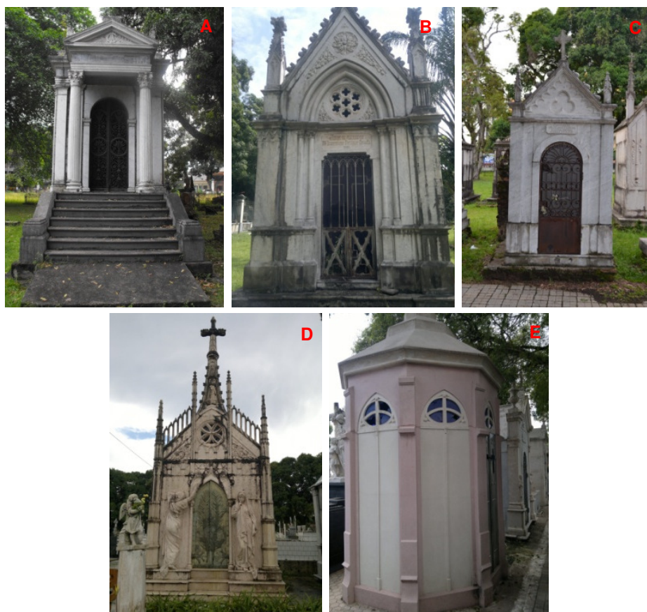
Figura 44: Mausoléu Assis Chermont (a); Mausoléu Pinheiro Corrêa (b); Mausoléu Danin (c); Mausoléu Brito Pontes (d); Mausoléu sem identificação (e).
