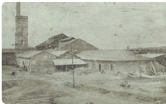
Figura 9: Primeira instalação da Companhia Vidraria Santa Marina em 1886.
