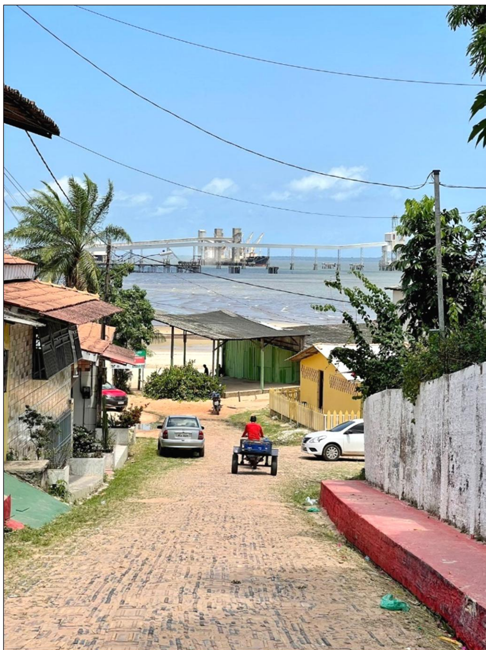
FIGURA 8 – BARCARENA, PARÁ: parte da estrutura da empresa Artemyn, a partir da praia de Vila do Conde Fonte: Carla Peixoto, 2022.
