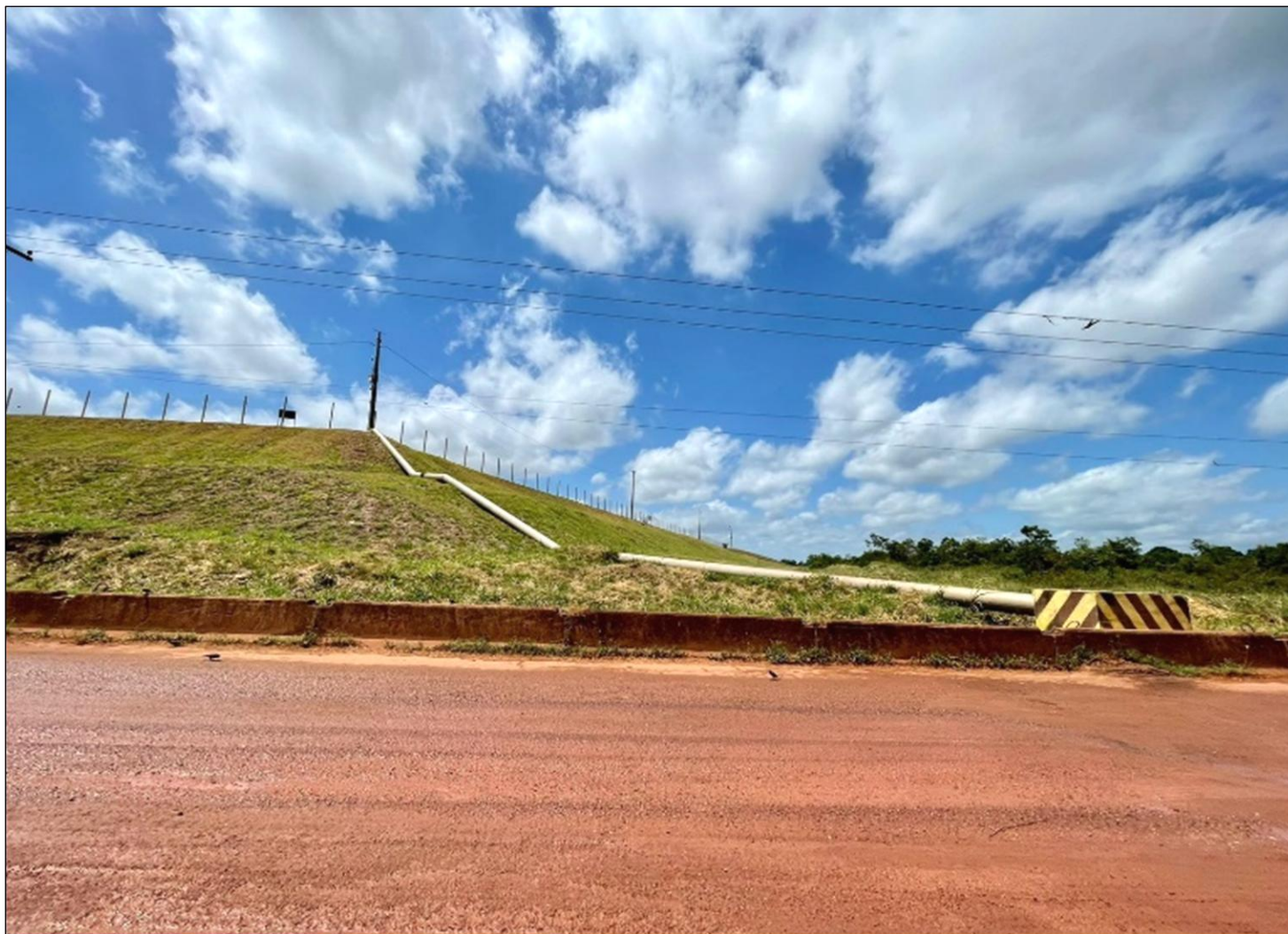
FIGURA 2 – BARCARENA, PARÁ: mineroduto da empresa Imerys Rio Capim Caulim S.A., no bairro Industrial Autoria: Carla Peixoto, 2022.
