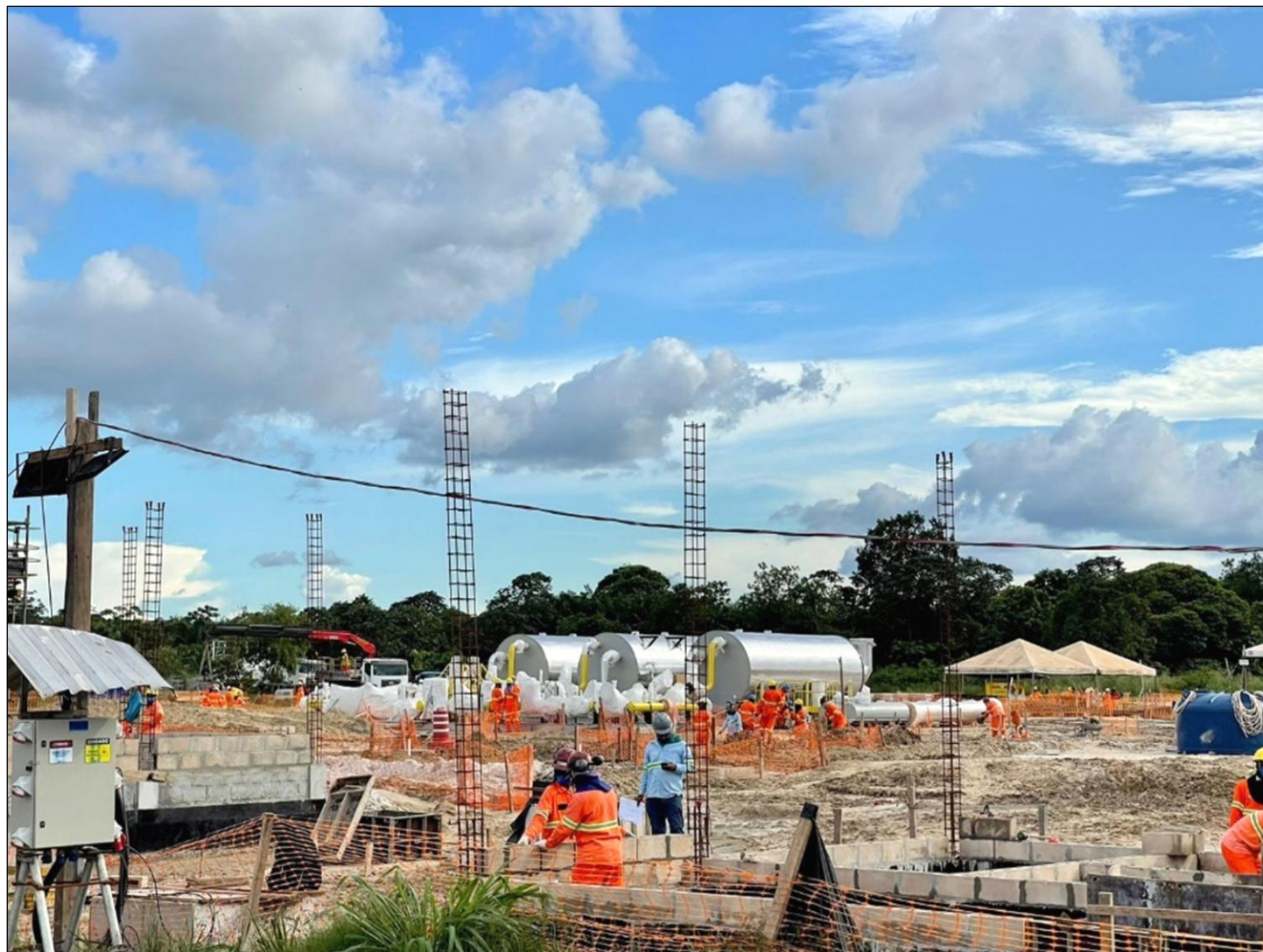
FIGURA 6 – BARCARENA, PARÁ: canteiro de obras da UTE Novo Tempo Barcarena, no Porto de Vila do Conde Fonte: Carla Peixoto, 2022.
