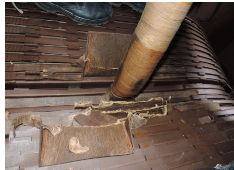
(b) Sinais de sobreaquecimento.
