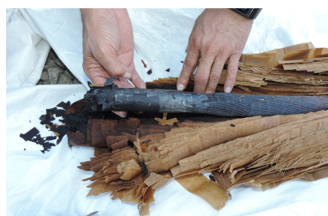
(b) Sinais de sobreaquecimento.
