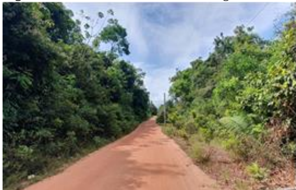
Figura 89 – Via de acesso a São Domingos
