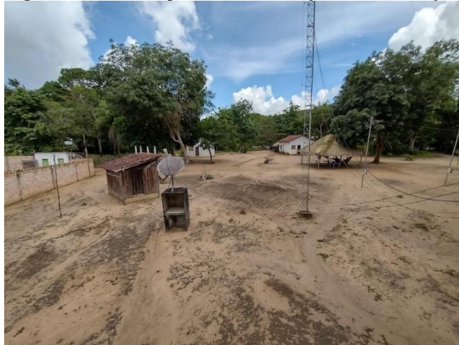
Figura 96 – Antenas para acesso a serviços de comunicação
