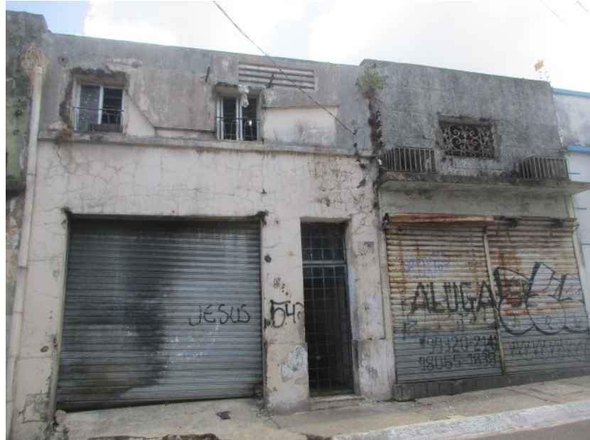
Figura 12- Casa de Campos Sales
