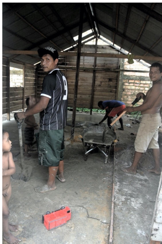
Figura 24 - Construcción de piso de cemento.
