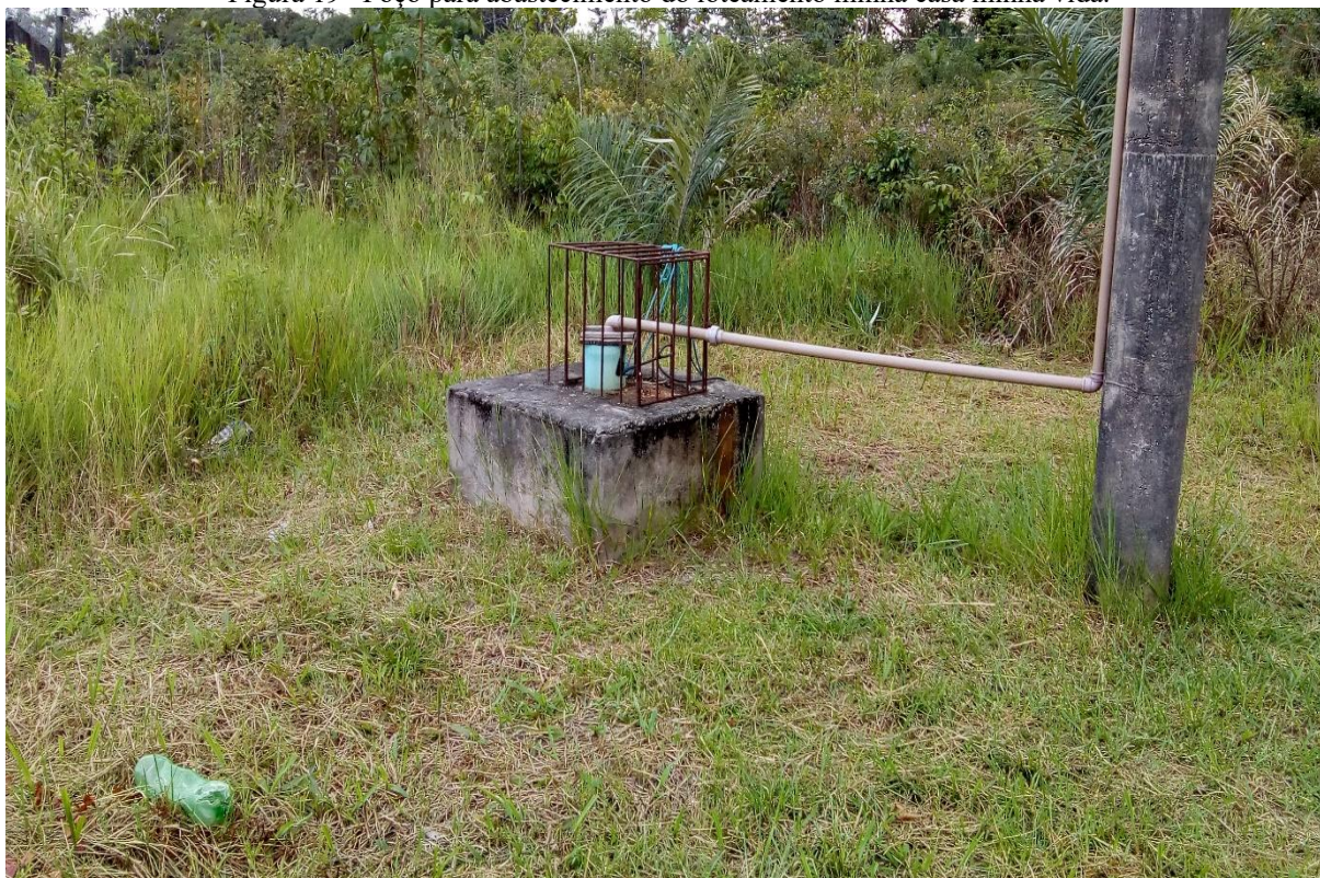
Figura 19– Poço para abastecimento do loteamento minha casa minha vida.
