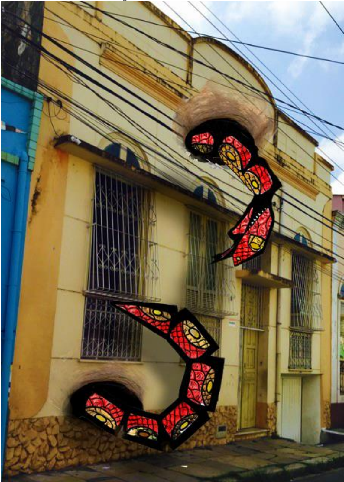
Figura 7 – Fachada da Casa Cuíra.
