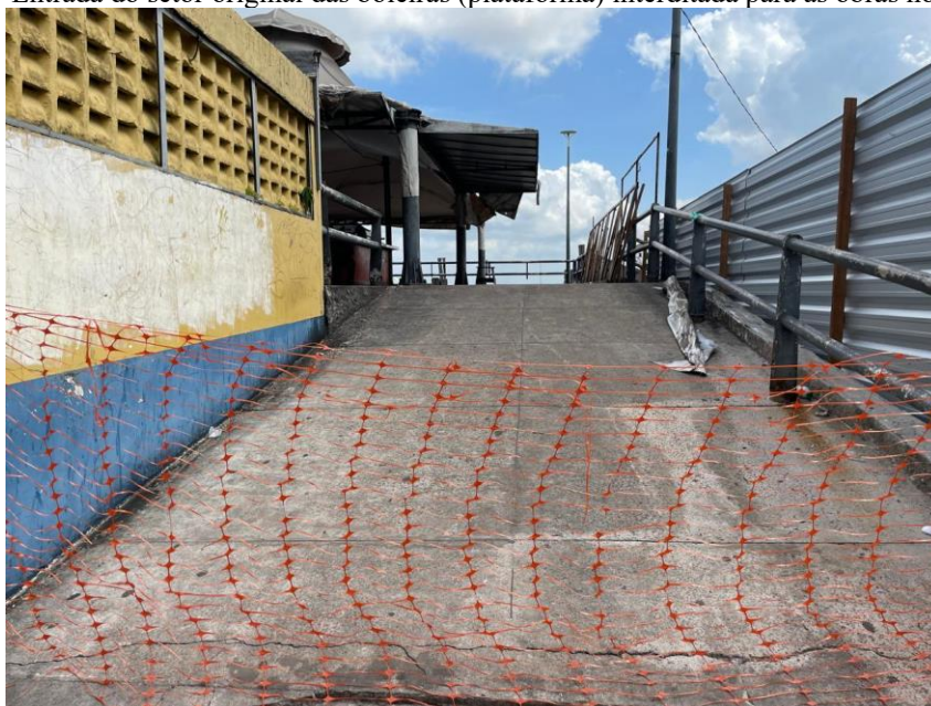
Figura 49 – Entrada do setor original das boieiras (plataforma) interditada para as obras no Ver-o-Peso
