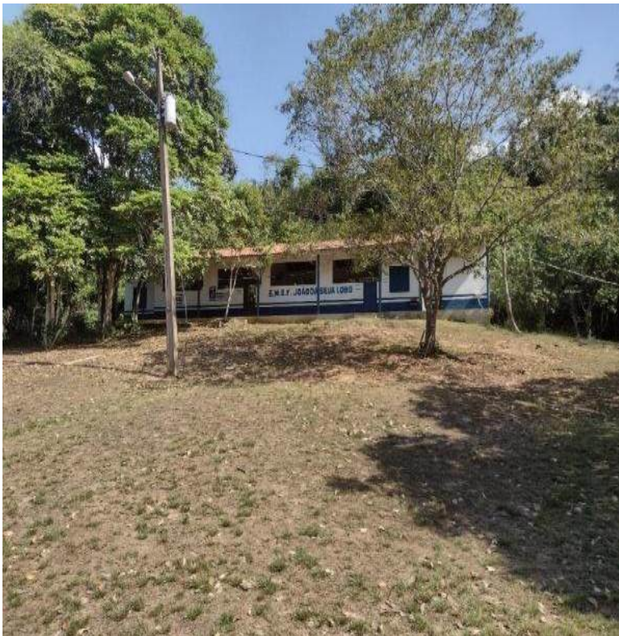
Figura 9 – Escola Municipal de Ensino Fundamental João da Silva Lobo.
