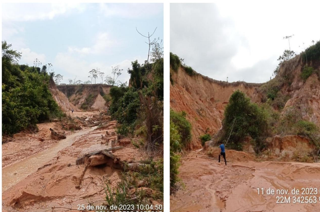
Figura 10: Formação de voçoroca e drenagem assoreada.
