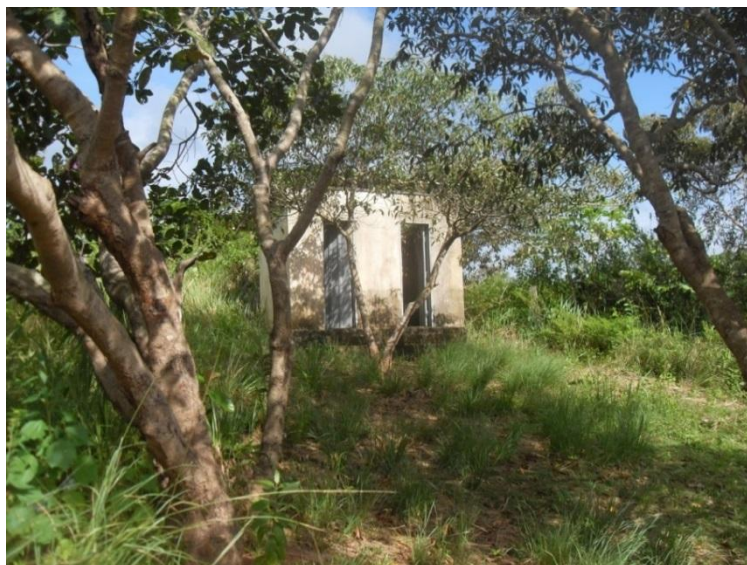
Figura 35: Banheiros da Escola Emília Rodrigues, na Cajazeirinha situados no meio do mato
