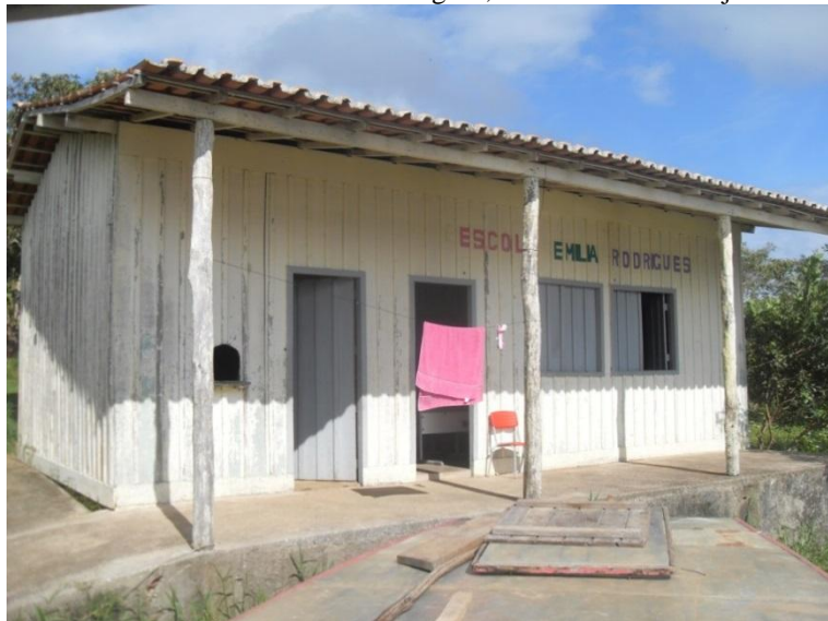
Figura 32: Fachada da Escola Emília Rodrigues, na Comunidade Cajazeirinha
