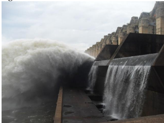
Figura 13: Vertedouros abertos da UHE Tucuruí
