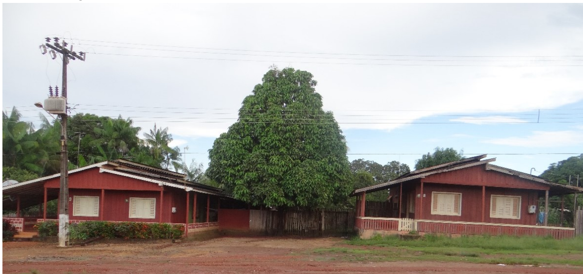
Figura 12 - Casas dos funcionários do INCRA, localizadas no distrito de Miritituba, construídas no âmbito do PIC Itaituba
