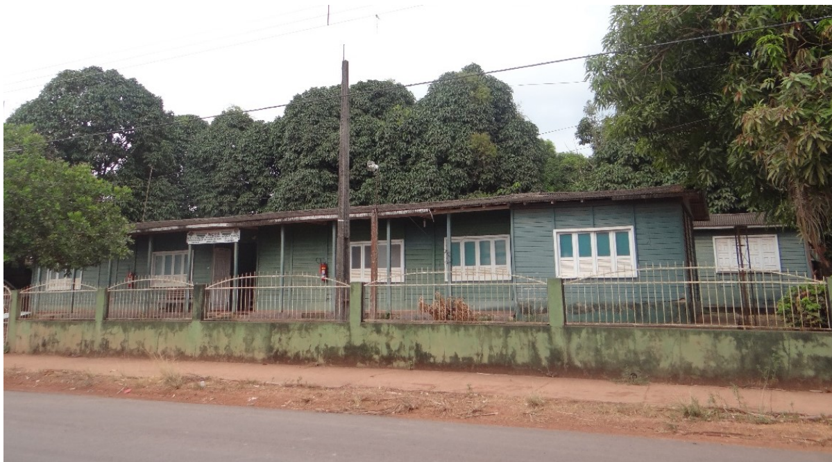
Figura 11 – Escritório do INCRA localizado no distrito de Miritituba, construído no âmbito do PIC Itaituba
