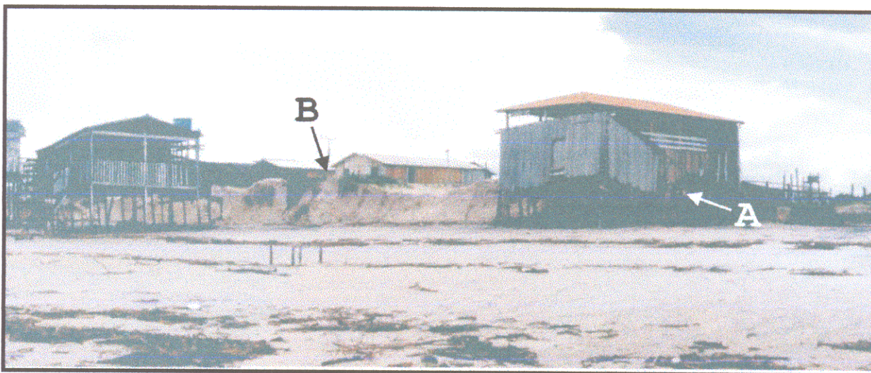
Figura 25 - Erosão atuante nas casas, onde observa-se a inclinação da mesma (A). Notar também a escarpa de erosão causada nas dunas frontais (B). Setor II.
