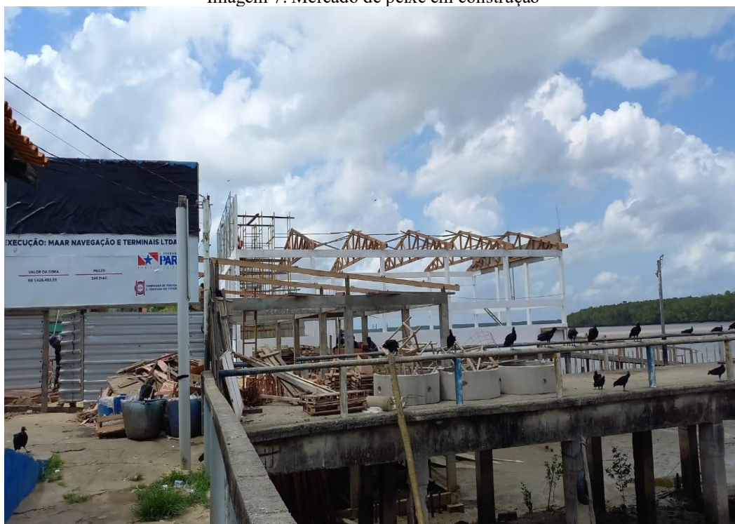
Imagem 7: Mercado de peixe em construção
