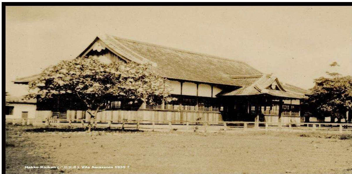
Figura 12 – Pavilhão Hakkou Kaikan , em Vila Amazônia (1940?)
