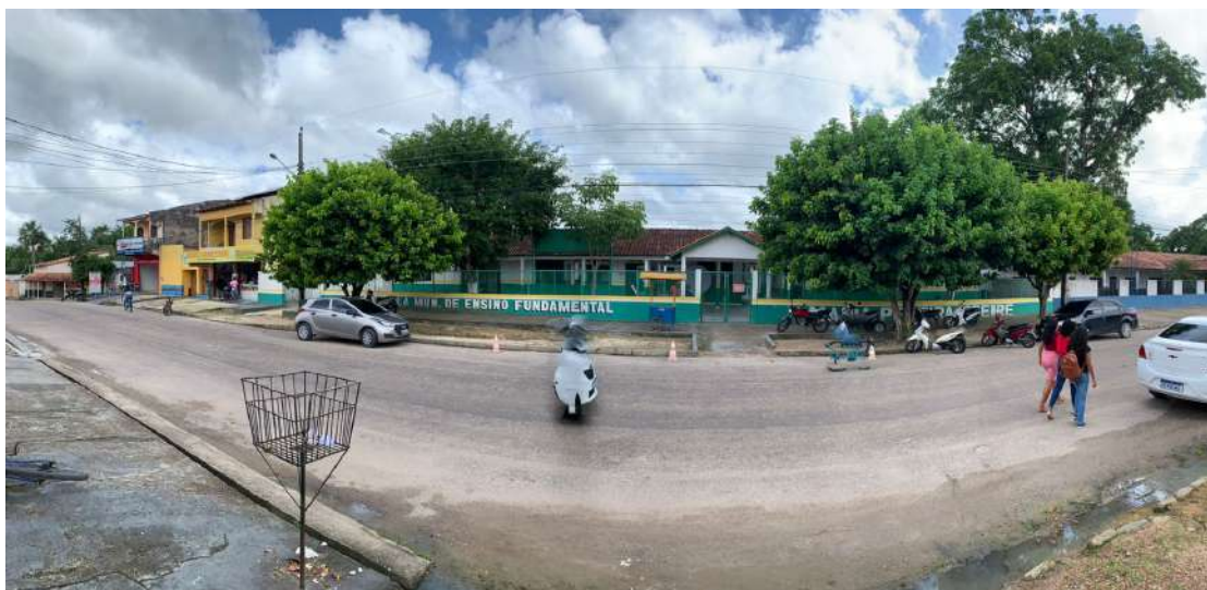
Figura 5- Fachada principal E. M. E. F. Maria Pereira Freire
