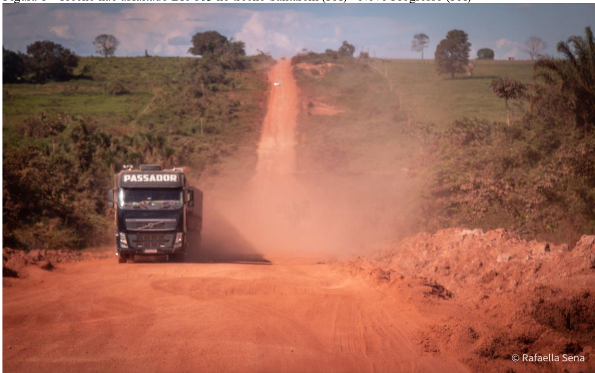
Figura 6 - Trecho não asfaltado BR-163 no trecho Santarém (PA) - Novo Progresso (PA)
