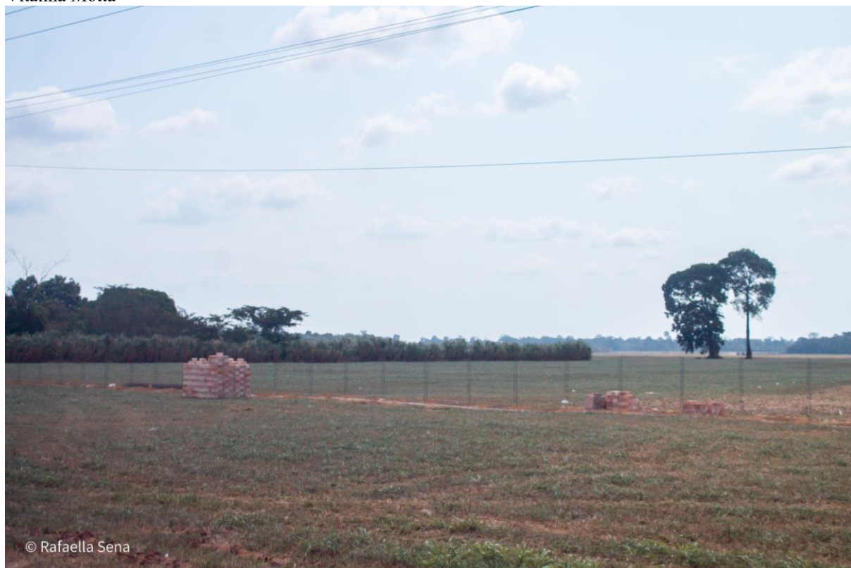
Figura 19 - Muro sendo erguido para cercar plantio de soja ao lado da Escola Municipal de Ensino Fundamental Vitalina Motta
