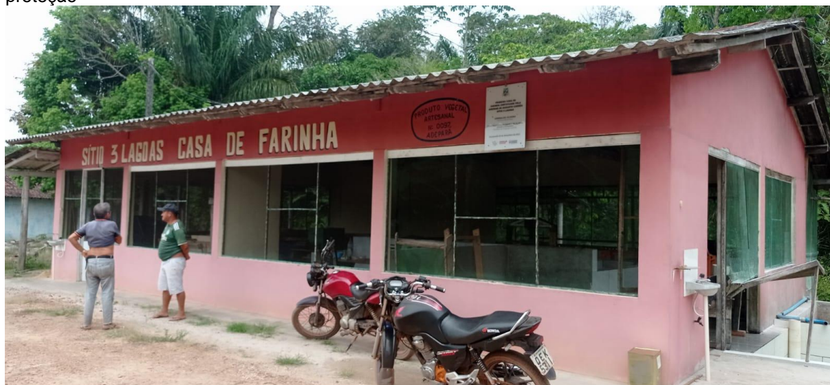
Figura 2 – Casa de farinha registrada na ADEPARÁ, com paredes/meias paredes e com telas de proteção
