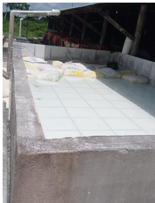
Figuras 4 e 5 – Tanques construídos para colocar as mandiocas de molho, em duas casas de farinha com registros na ADEPARÁ
