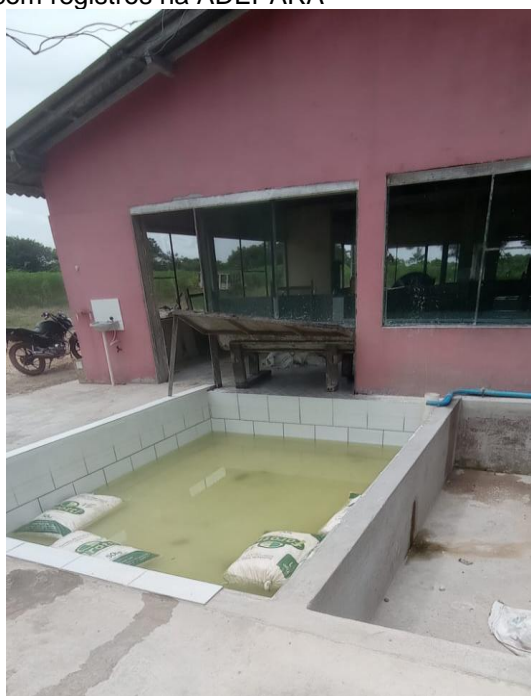
Figuras 4 e 5 – Tanques construídos para colocar as mandiocas de molho, em duas casas de farinha com registros na ADEPARÁ
