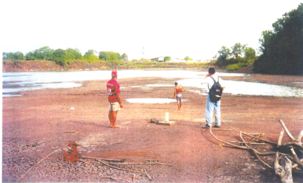
Figura 1.3: Vista da bacia de decantação localizada na Área Industrial da ICOMI, com capacidade de 55.000 m 3 , na qual eram depositados os rejeitos do processo de pelotização.
