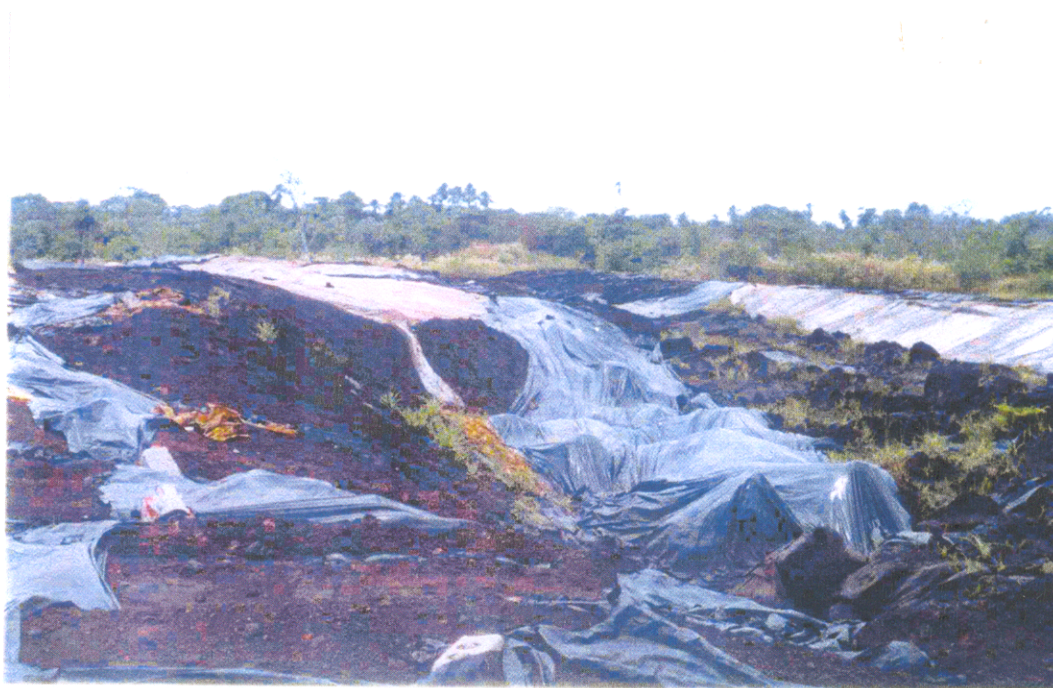
Figura 1.5: Vista das pilhas de rejeito remanejadas para uma área ao norte da Área Portuária e Industrial da ICOMI. Encobertas por lonas plásticas deterioradas.
