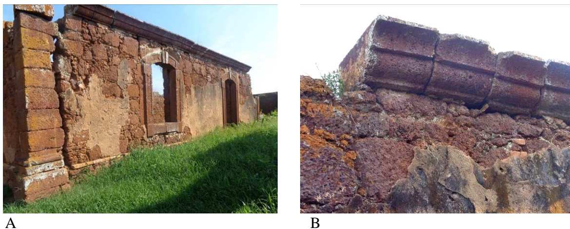
Fig. 30. (A) Edificação da praça central do RFPB onde se observa o tratamento em destaque das pilastras de cunhais, molduras e cimbalhas dos beirais em blocos de rochas aparentes entalhadas de forma especial conforme função que contrastava com os panos de paredes em alvenaria mista de blocos de crostas com tijoleiras cerâmicas que eram encobertas por argamassa de reboco caiada. (B) Detalhe dos blocos que compõem cimbalhas que apoiavam a cobertura em beiral.
