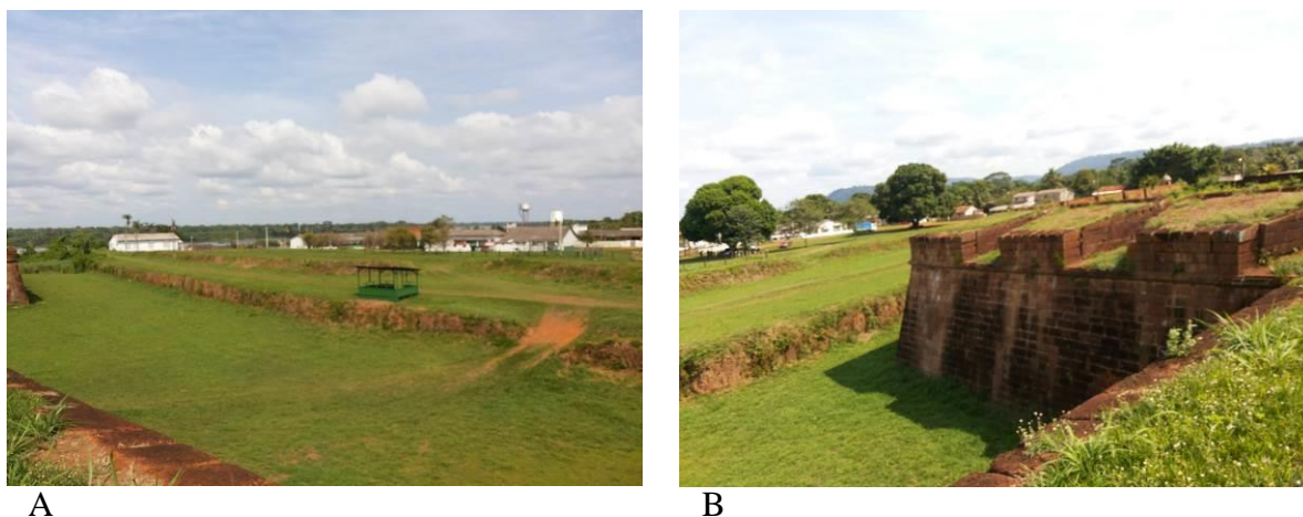
Fig. 42. (A) Vista geral a partir do terrapleno, onde se observa o perfil laterítico em frente à muralha norte que se configura como o contorno da contra escarpa do fosso seco. (B) Vista a partir da mureta superior do terrapleno norte onde se observa o fosso seco formado pela face do baluarte de Santo Antônio de Pádua e a contra escarpa representada pelo perfil laterítico in situ . Fotos: MLC, 2015.
