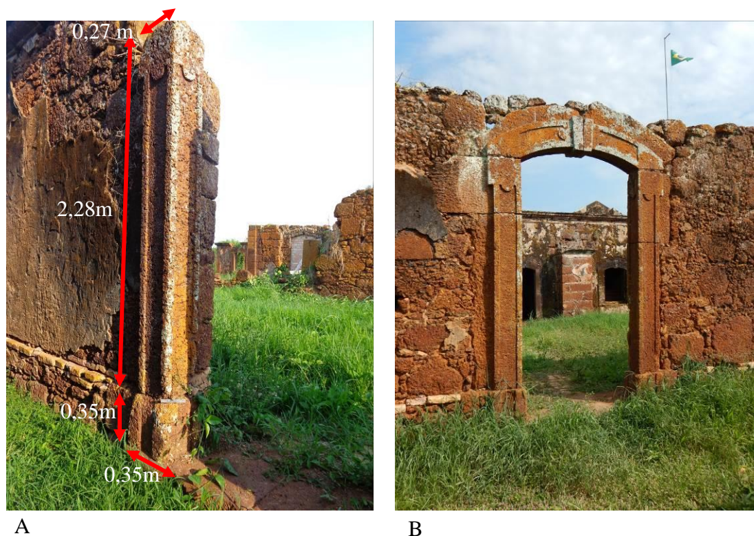
Fig. 30. (A) Edificação da praça central do RFPB onde se observa o tratamento em destaque das pilastras de cunhais, molduras e cimbalhas dos beirais em blocos de rochas aparentes entalhadas de forma especial conforme função que contrastava com os panos de paredes em alvenaria mista de blocos de crostas com tijoleiras cerâmicas que eram encobertas por argamassa de reboco caiada. (B) Detalhe dos blocos que compõem cimbalhas que apoiavam a cobertura em beiral.
