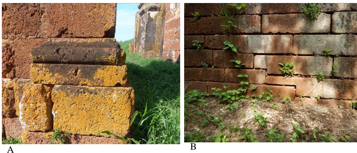
Fig. 28. (A) Diferentes formas e dimensões de blocos regulares compondo a base de pilastras das edificações internas da praça do RFPB. (B) Detalhe de blocos com encaixes tipo “L” na base da muralha da face oeste do baluarte Santo André Avelino. Fotos: RN 2015(A), MLC 2015 (B).
