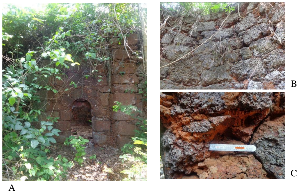
Fig. 4. (A) Ruínas do forno para queima e produção de tijoleiras cerâmicas com estrutura de seção circular e paredes em blocos de crostas lateríticas. (B) Vista interna do forno cujas paredes afunilam-se em direção ao topo. (C) Manchas enegrecidas nas rochas e argamassas das paredes internas do forno pelas altas temperaturas atingidas durante a queima do material cerâmico.
