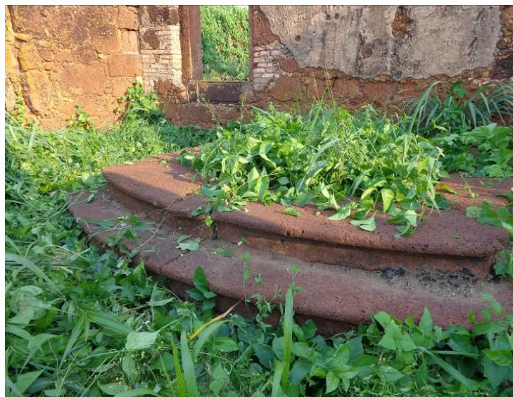
Fig. 32. (A) Escadaria ao lado do calabouço em blocos regulares e contrafiados de crostas lateríticas. (B) Pisos em blocos curvos que compunham o altar mor da Capela em crostas maciças.
