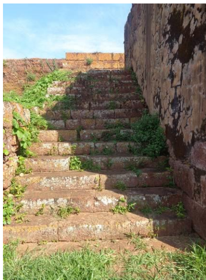
Fig. 32. (A) Escadaria ao lado do calabouço em blocos regulares e contrafiados de crostas lateríticas. (B) Pisos em blocos curvos que compunham o altar mor da Capela em crostas maciças.
