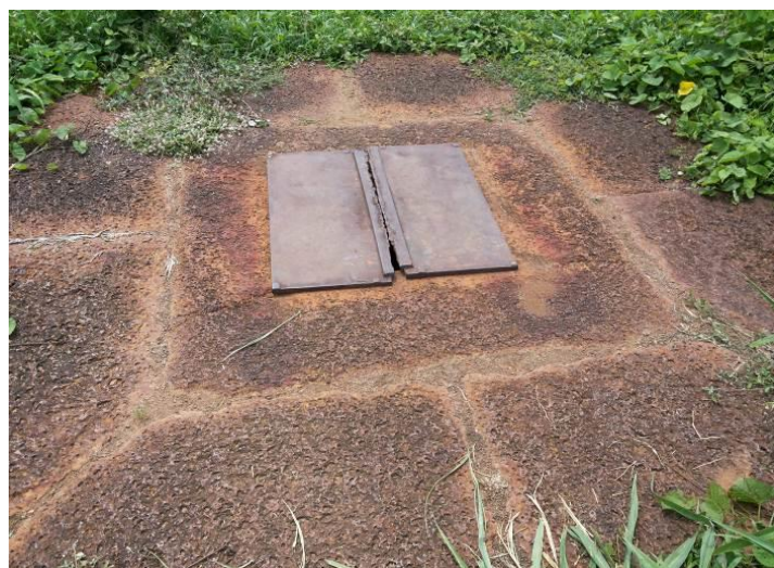
Fig.33. (A) Fosso central com fechamento em folha dupla de chapa metálica em ferro forjado, cercada por blocos de crostas lateríticas em composição quadrangular no nível de piso da própria praça central. (B) Pavimentação do acesso principal da praça d'armas em blocos rochas que podem ser apenas demarcadas no piso posto que a estrutura foi erguida no nível do topo do perfil laterítico.
