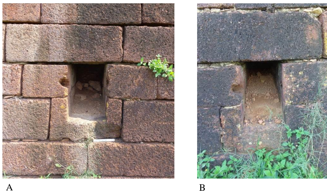
Fig. 28. (A) Diferentes formas e dimensões de blocos regulares compondo a base de pilastras das edificações internas da praça do RFPB. (B) Detalhe de blocos com encaixes tipo “L” na base da muralha da face oeste do baluarte Santo André Avelino. Fotos: RN 2015(A), MLC 2015 (B).
