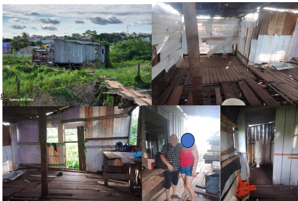
Figura 12: Residência para ser desapropriada.
