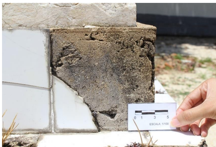
Figura 3 – Lacuna no azulejo causada por destacamento, túmulo C26.
