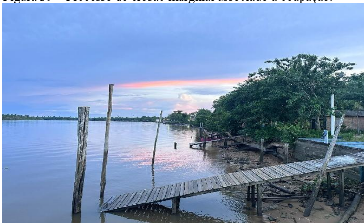
Figura 39 – Processo de erosão marginal associado à ocupação.
