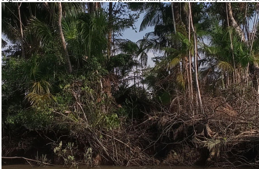
Figura 6 – Processo erosivo nas margens fluviais, decorrente da supressão das espécies de mangue
