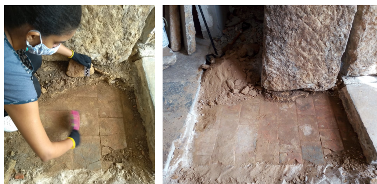
Figura 57: Piso em tijoleira evidenciado durante a obra. Fotos: Juliana da Mata.
