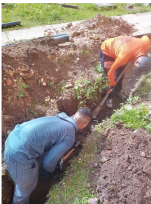
Figura 55: Escavação de uma trincheira para as obras de fiação elétrica
